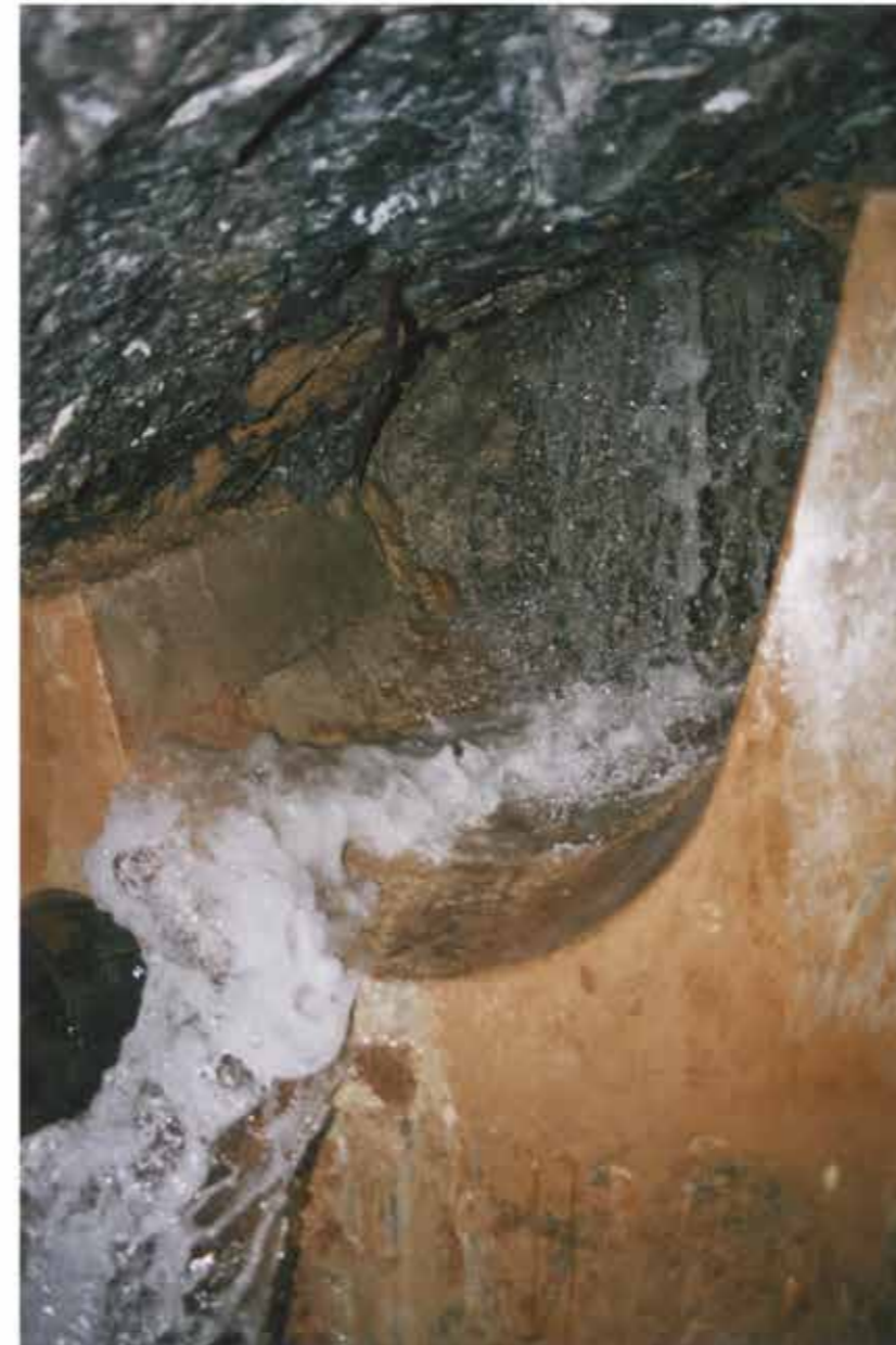
Zwischen 25 und 35 l/sec liefert die Stollenquelle und dies relativ konstant. Unter normalen Bedingungen ist dies ausreichend für die Versorgung des ganzen Dorfes. Der durchschnittliche Wasserbedarf schwankt zwischen 20 und 30 l/sec. (Foto: Chronos)
