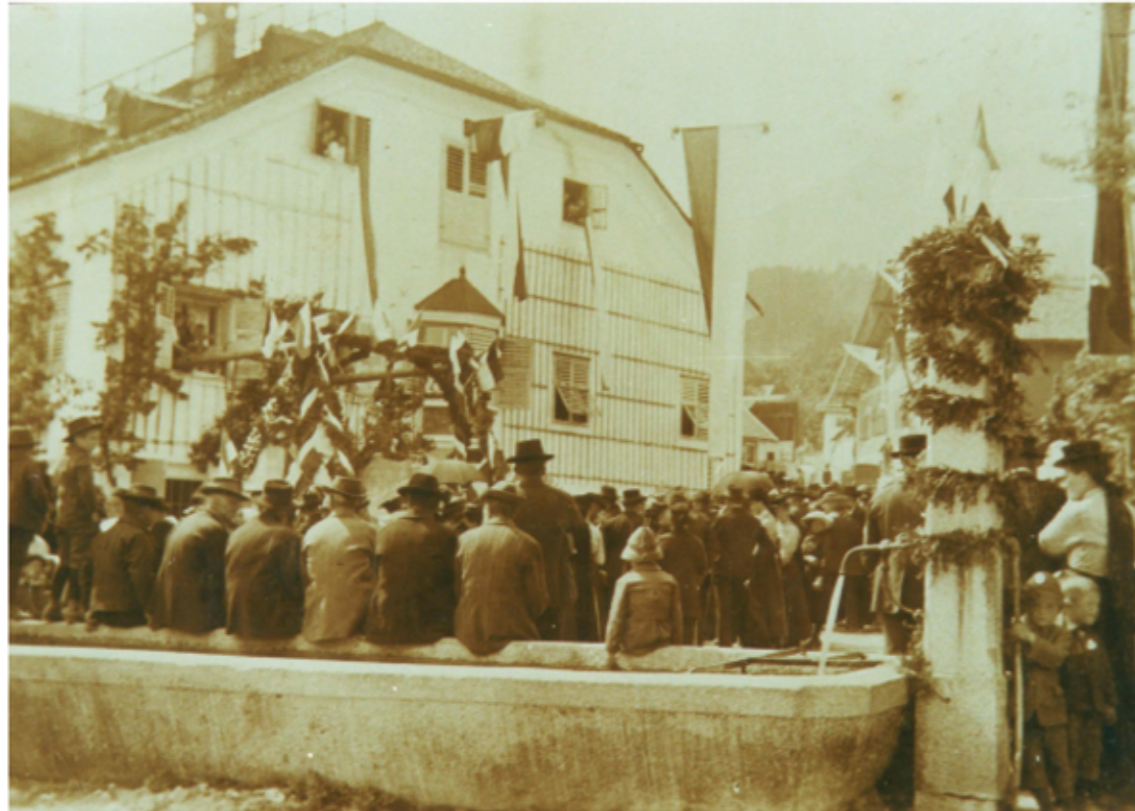
Nach wiederholten Klagen über verschmutzte Dorfbrunnen in der Zeit um 1860 wurden mehrere dieser einst hölzernen Brunnen durch solche aus massivem Öztaler Granit ersetzt. Sie prägen noch heute das Thaurer Dorfbild. (Foto: Bestand Dorfarchiv)
