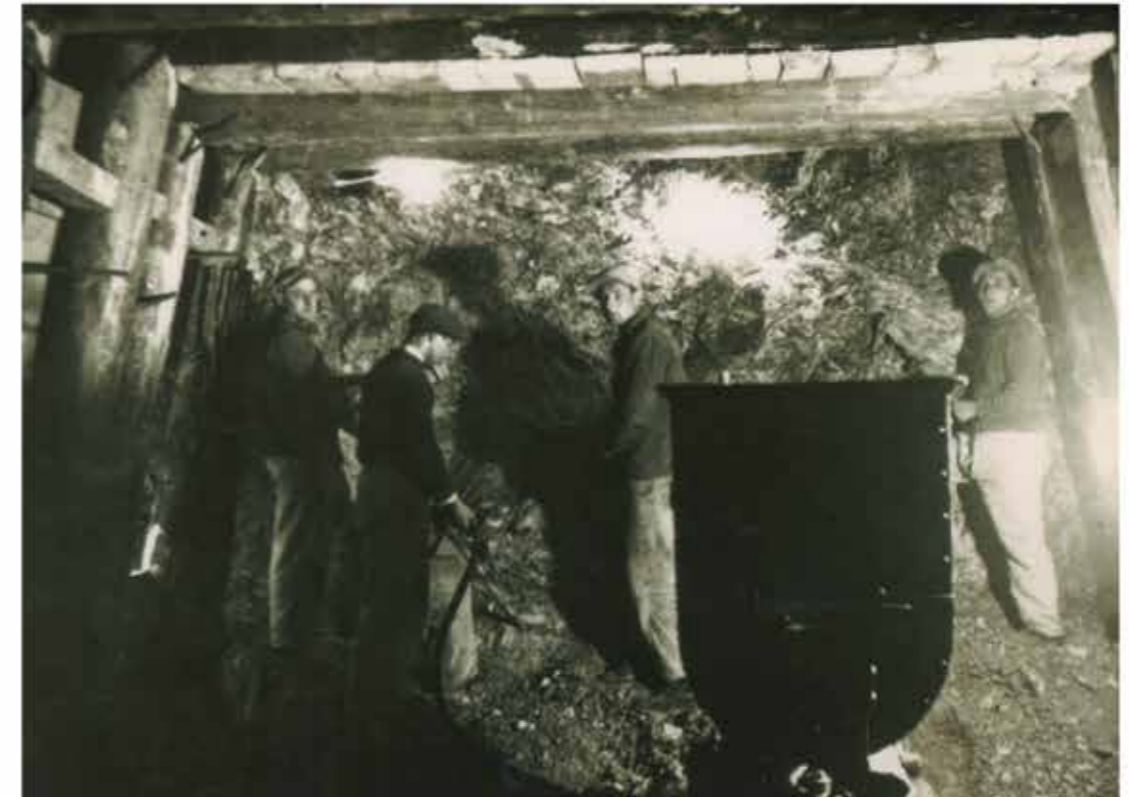
Der zügige Stollenvortrieb wurde vereinzelt durch weiche Gesteinsschichten (Partnach-Dolomit) erschwert. Während der Bauarbeiten wurde der Stollen provisorisch ausgezimmert. (Bestand: Sammlung Hans Spötl)
