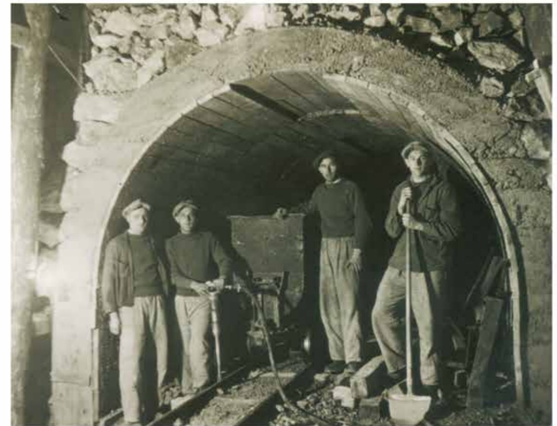
Anschließend wurden diese Bereiche durch Vollausmauerung gesichert - hier im Bild in ca. 230 m Tiefe. (Bestand: Sammlung Hans Spötl)
