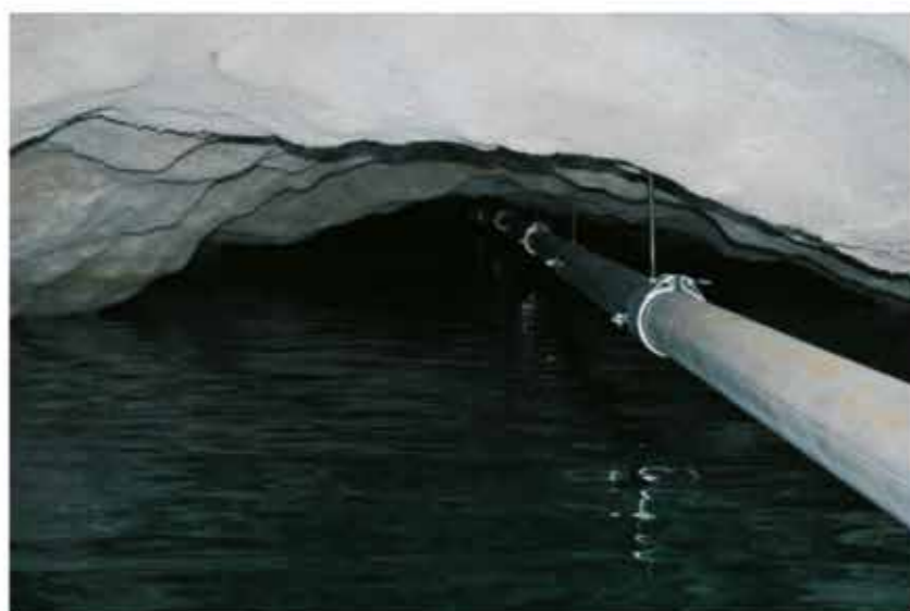
Ein Blick in die stets randvolle Kaverne neben dem Stolleneingang. Sie fasst 500 m 3 Wasser und wurde 1959 errichtet. (Foto: Chronos)
