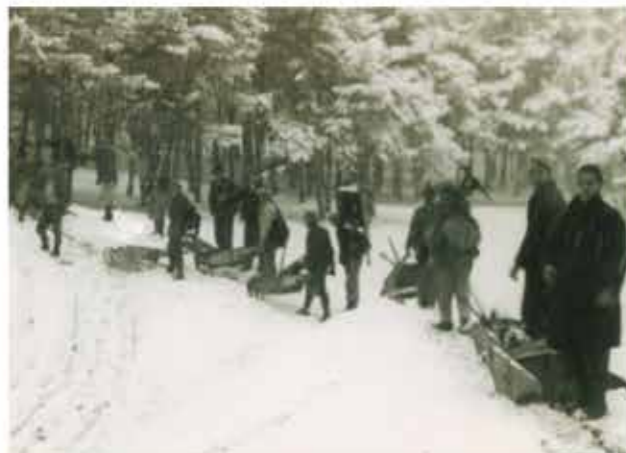
Bei heftigem Schneetreiben zogen die Mitarbeiter des „Freiwilligen Arbeitsdienstes“ am 14. November 1933 mit ihren Arbeitsgeräten hinauf nach Kapons. Im Hintergrund der bewaldete Kaponsboden. (Bestand: Sammlung Hans Spötl)
