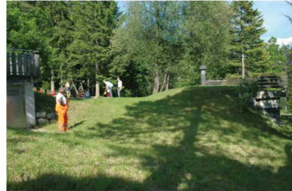
Der „Spielplatz im Moos“. Links die Quellstube, rechts die Pumpstation. Sie pumpt Wasser in den „Hochbehälter Moos“ (am Adolf-Pichler-Weg) hinauf. Vor 5 Jahren wurde auch die Moosquelle vom Netz genommen. (Foto Chronos)
