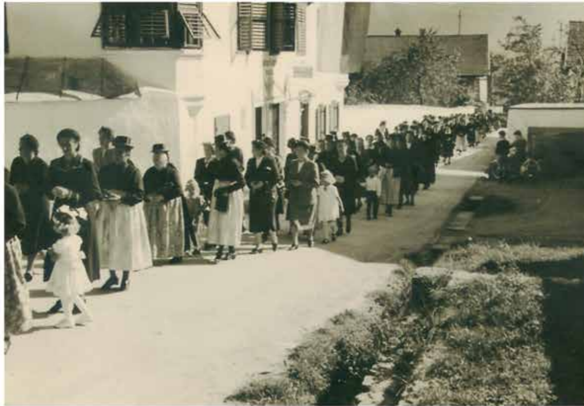
Ältere Thaurer erinnern sich noch daran, wie dieses Bachl vom Platzlbrunnen beim Stangl am Rand der Bauerngasse hinunter geronnen ist. Unter den Kindern hieß es damals: „Kimm, gemma Bachlhupfn!“ (Foto: Bestand Felderer Franz)
