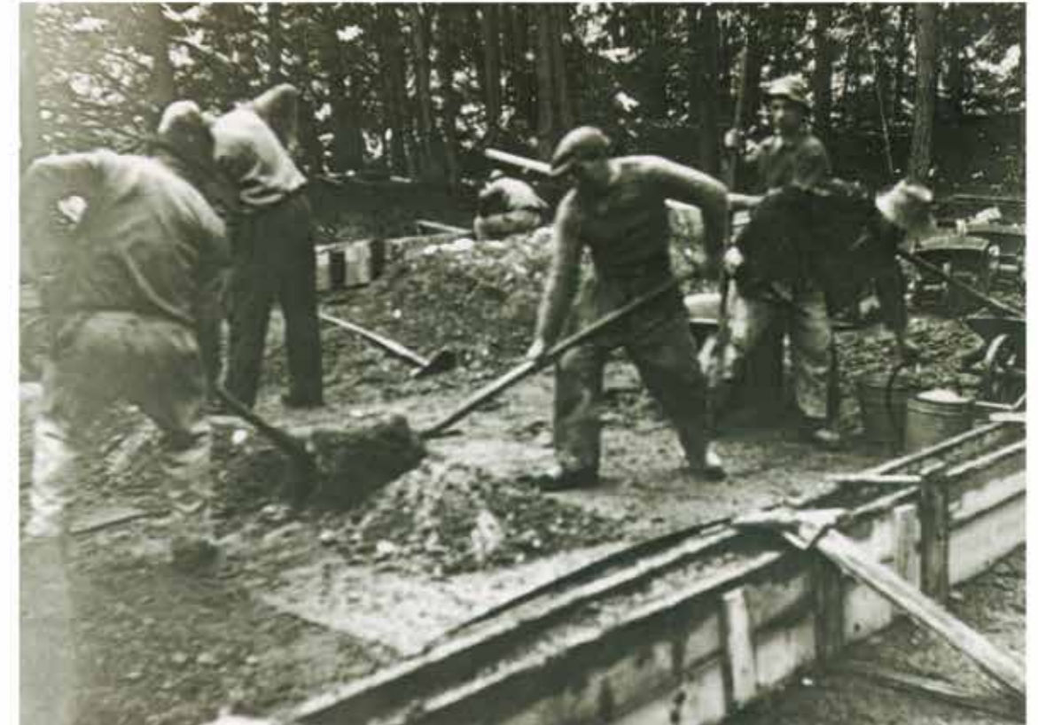
Der Beton für die Barackenfundamente wurde natürlich noch von Hand gemischt. (Bestand: Sammlung Hans Spötl)
