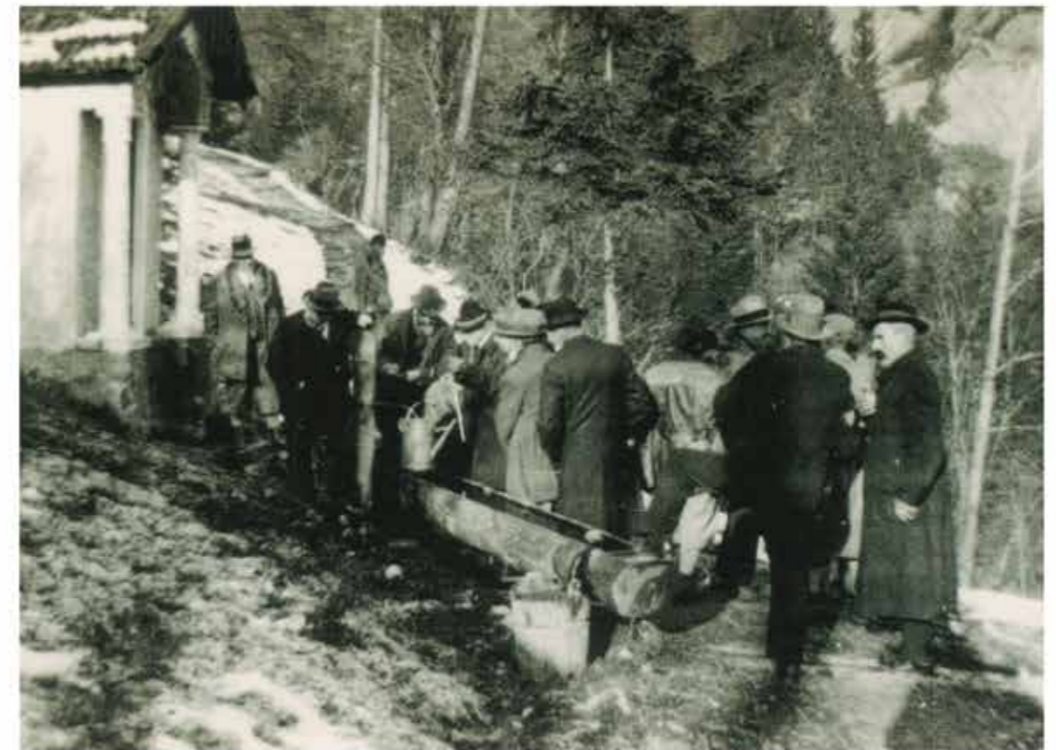
Das Wasser für die Betonarbeiten wurde in einer eigenen Leitung vom Bründl hinter der Romedikirche herübergeführt. (Bestand: Sammlung Hans Spötl)
