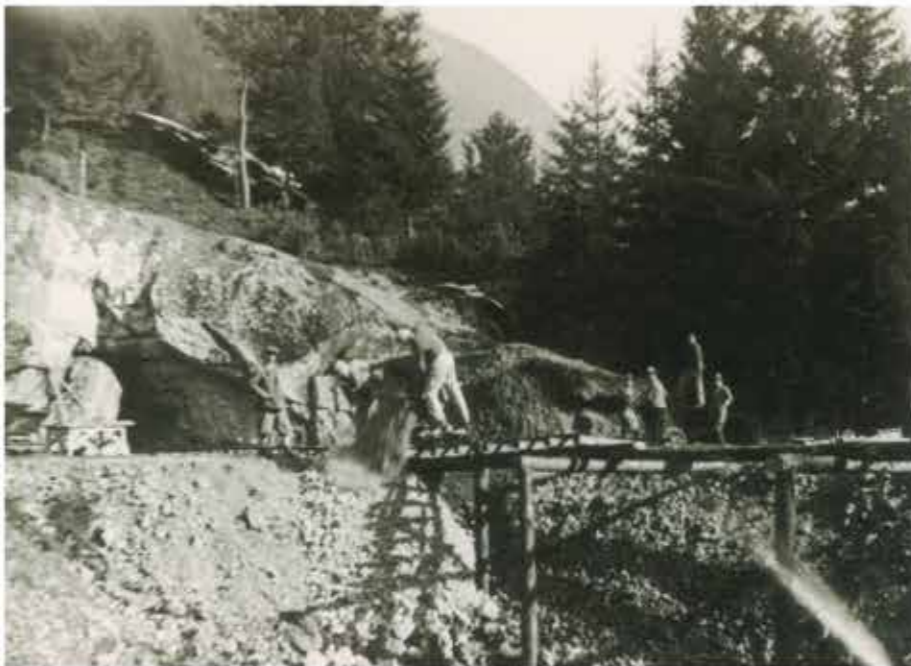
Das Ausbruchsmaterial wurde unmittelbar vor dem Stollenmundloch aufgeschüttet. (Bestand: Sammlung Hans Spötl)
